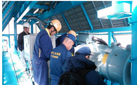
交流原動機・減速機の更新
